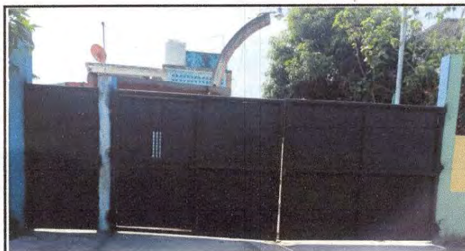
Foto 3: Proceso de Mantenimiento a portón de metal
