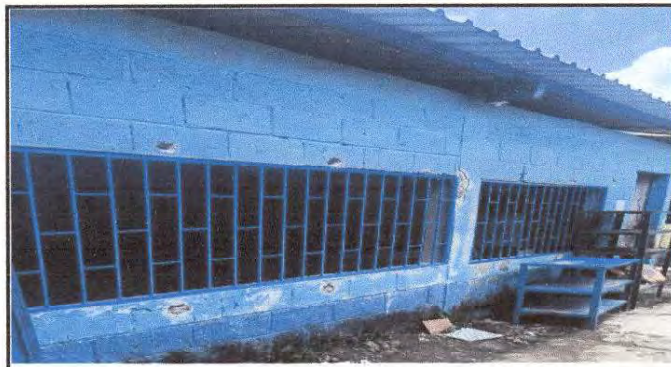
Foto 4: Proceso de instalación de balcones en ventanas
