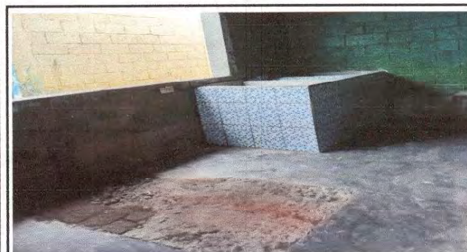
Foto 3: Proceso de Construcción de pila de dos lavaderos
