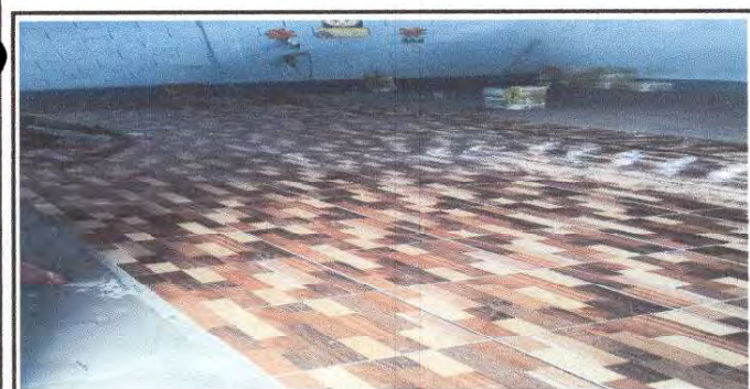
Foto 5: Proceso de cambio de piso cerámico
