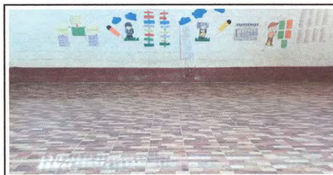
Foto 6: Proceso de cambio de piso cerámico
