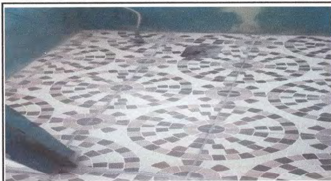
Foto 2: Proceso de cambio de piso cerámico en sanitarios
